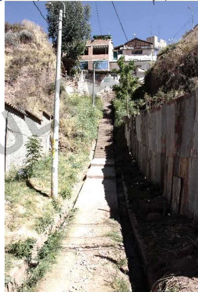
Imagen N° 72: Pasaje Simón Bolívar con canales de evacuación de aguas pluviales.
